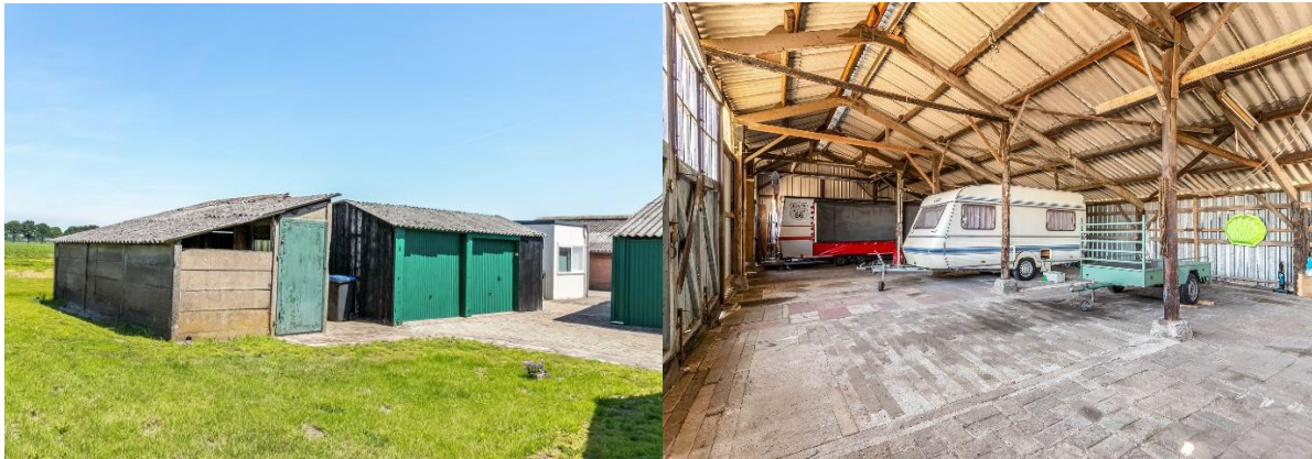
Figuur 18: Foto's te slopen gebouwen
