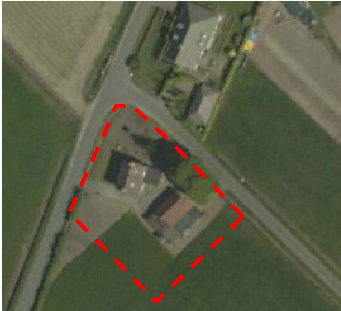
Luchtfoto van het plangebied
