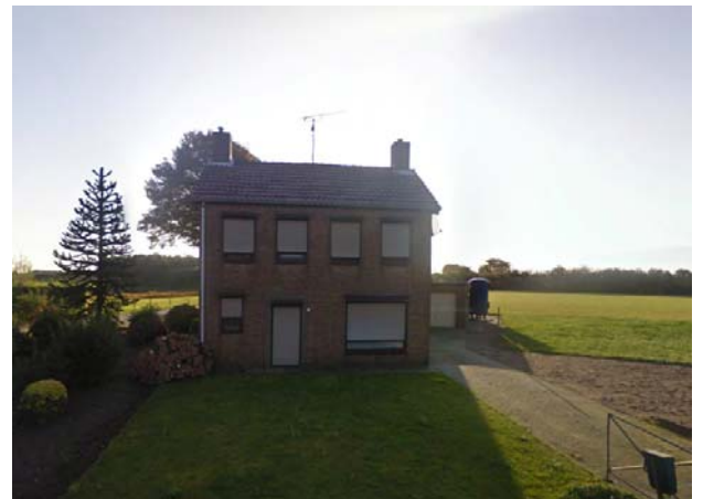
Vooraanzicht bestaande woning
