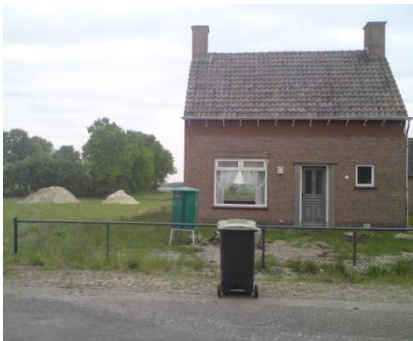
Vooraanzicht van de te vervangen woning met links en achter de woning de geplande bouwlocatie voor de nieuwe woning met berging.
