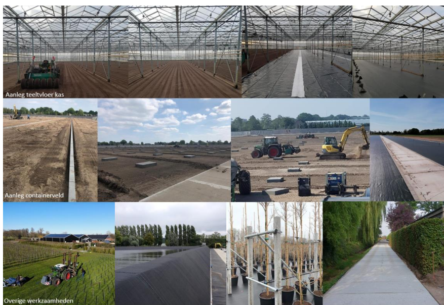
Figuur 3: Werkzaamheden Traycon Projecten B.V.
