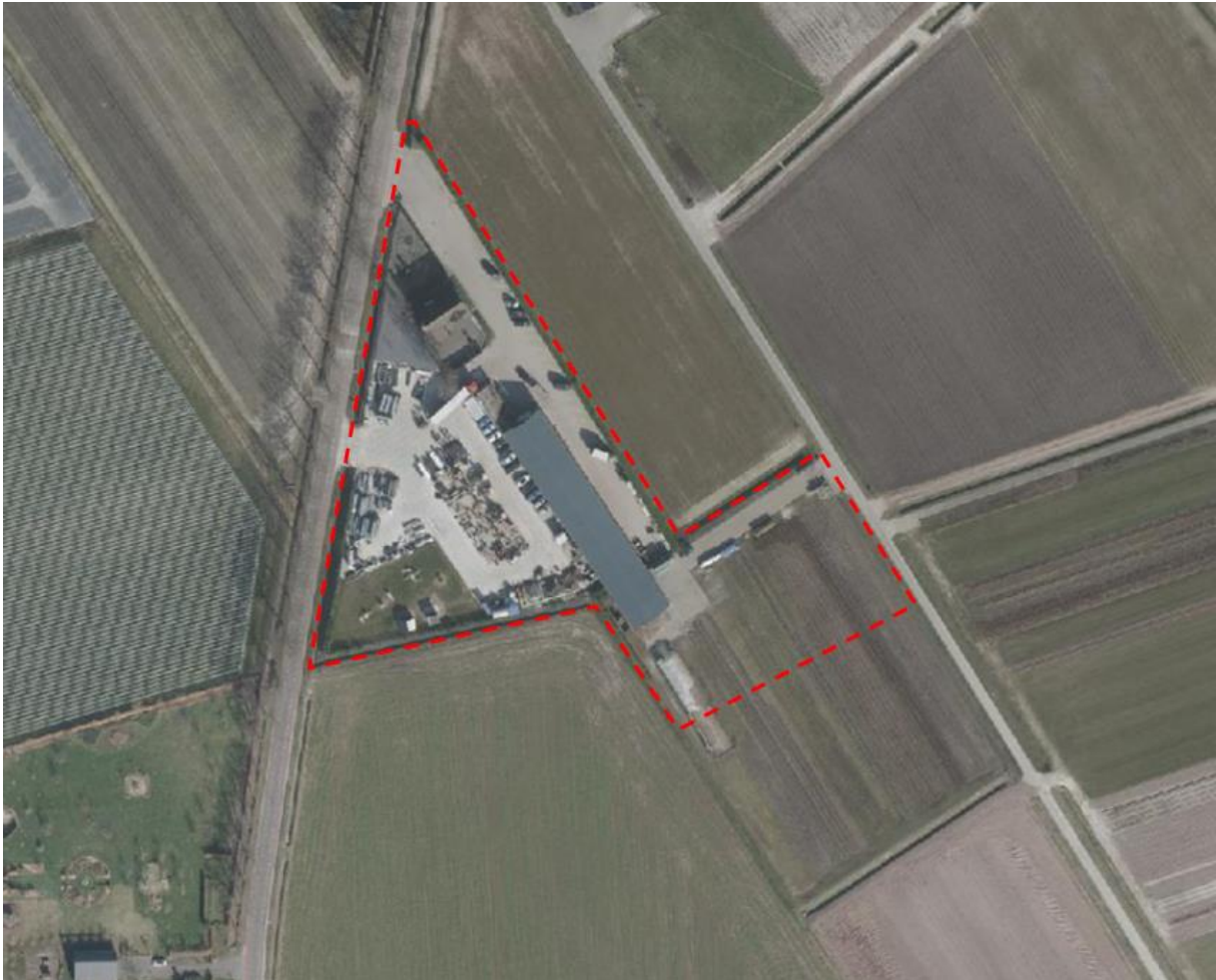
Figuur 1: Luchtfoto planlocatie
