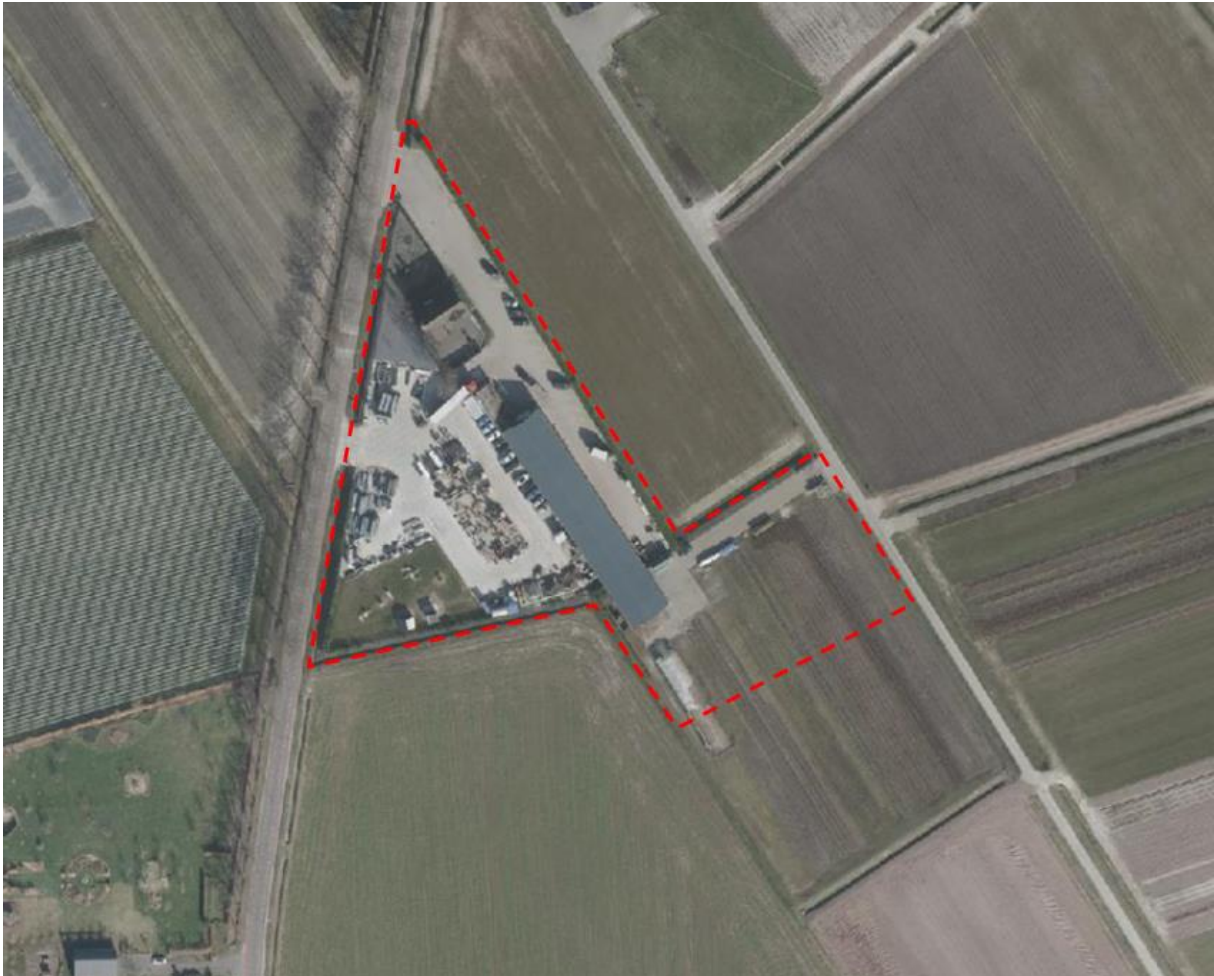
Figuur 1: Luchtfoto planlocatie
