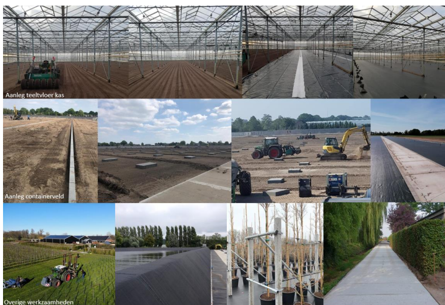
Figuur 3: Werkzaamheden Traycon Projecten B.V.
