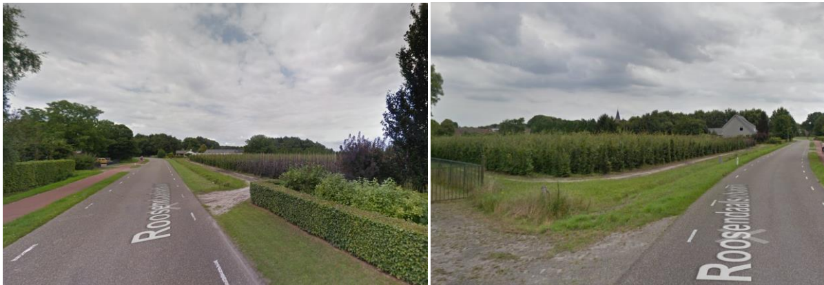
Figuur 4: Foto bestaande situatie
