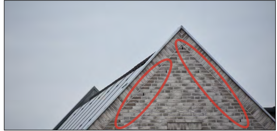
Figuur: in de nieuwbouwwoningen die recent gebouwd zijn ten westen van het plangebied zijn open stootvoegen aanwezig (rode markeringen). Via deze openingen kunnen vleermuizen de spouw bereiken waar ze verblijfplaatsen kunnen hebben.
