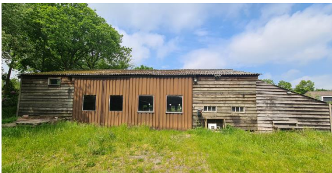
Figuur 7: Bijgebouw in het zuidoosten van het plangebied, gezien vanuit het oosten
