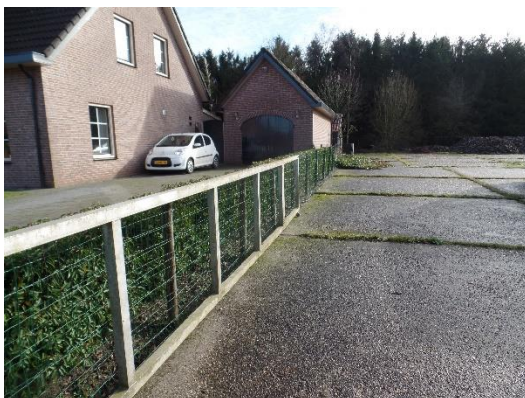
Betonplaten langs noordelijk perceelgrens
