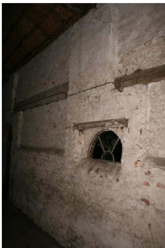
Gevel met penanten en kalk
