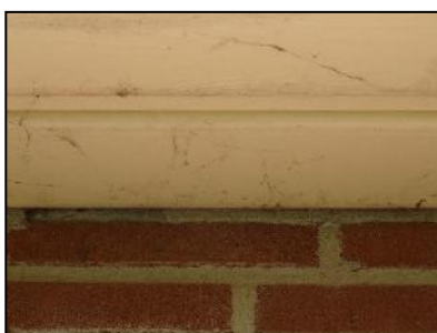
Figuur 10. Gebouw 2, strak aangesloten betimmering van de dakrand.
