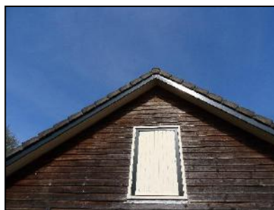
Figuur 5. Gebouw 1, timmerwerk tegen de zuidwestelijke gevel.
