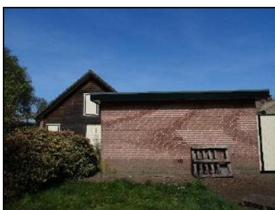
Figuur 9. Zuidwestelijke zijde van gebouw 2.
