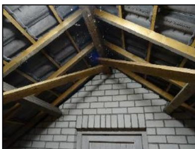
Figuur 7. Gebouw 1, pannendak zonder onderdak.
