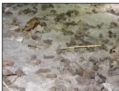
Figuur 14. Gebouw 3, uitwerpselen op de betonnen vloer.
