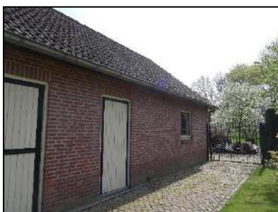
Figuur 6. Gebouw 1, Noorwestelijke gevel gelegen aan een tuin.
