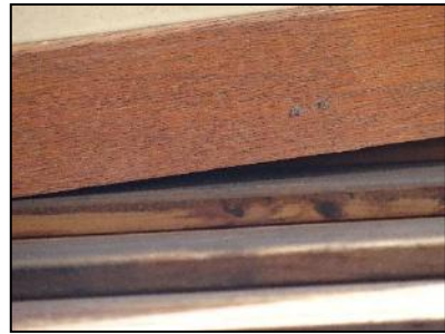
Figuur 23. Gebouw 1, ruimte tussen het timmerwerk aan de zuidwest zijde.
