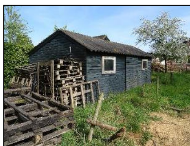
Figuur 11. Gebouw 3, westzijde met gestapelde houten pallets.
