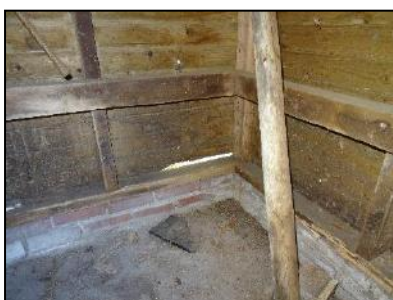
Figuur 12. Gebouw 3, voorbeeld van opening in de houten wand.
