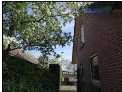
Figuur 19. Zuidgevel gebouw 1 (rechts) vormt smalle doorgang met gebouw 5 (links).
