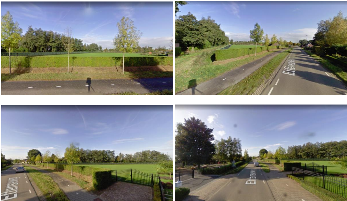
Figuur 4: Foto's bestaande situatie
