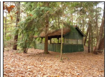
Figuur 6. Blokhut aan de zuidwestzijde van de onderzoekslocatie.
