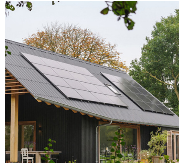
Zonnepanelen verwerkt in het dakvlak
