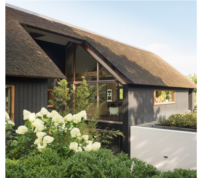
Verbijzonderingen in strakke gevel
