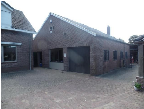
Bedrijfsschuur gezien vanaf de voorkant met kantoorruimte.
