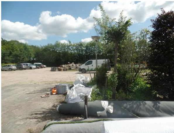
Zicht op het bouwvlak waarop de nieuwe schuur gevestigd wordt in west-oost richting.
