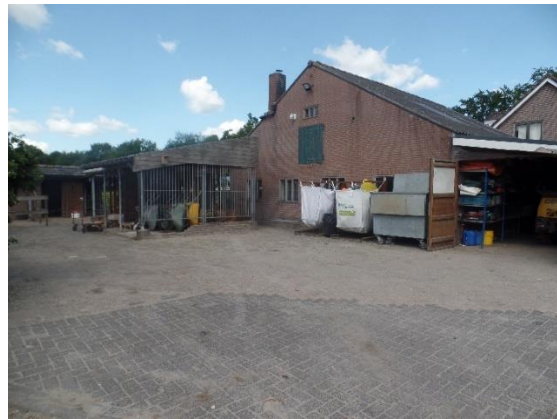
Schuur gezien van de achterkant. Uiterst rechts de aanbouw
