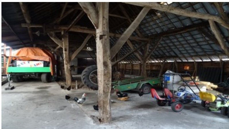
Vlaamse schuur met houten draagconstructie en golfplaten overkapping. Foto: K. van Veen | Ecoresult B.V.
