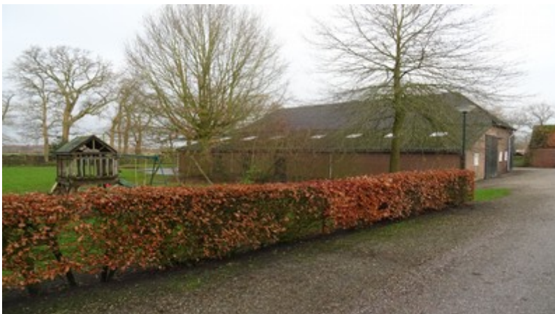
Vlaamse schuur met aan de voorzijde het aangebouwde schuurdeel Foto: K. van Veen | Ecoresult B.V.
