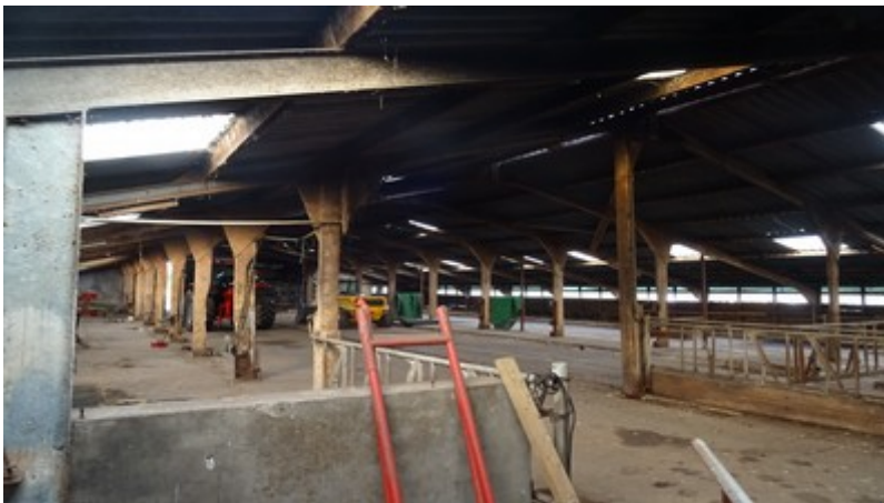
Binnenzijde schuur met asbest dak. Foto: K. van Veen | Ecoresult B.V.
