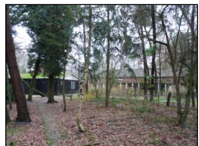
Figuur 8. Zuidelijk/oostelijk gedeelte met bijgebouw en aanbouw.
