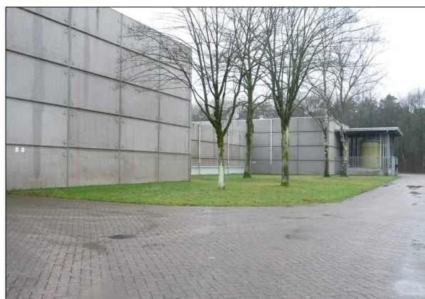
Figuur 6. De zuidwestzijde van het waterproductiebedrijf
