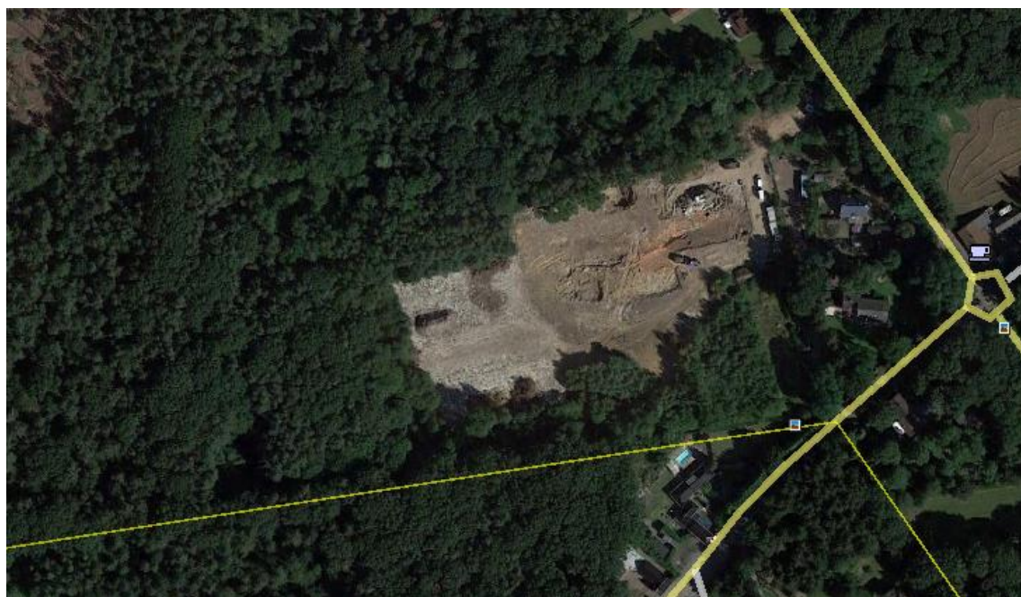
Figuur 1.3 Bestaand terrein, na verwijderen verharding en bebouwing
