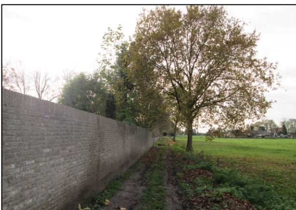
Muren langs zandpad (direct naast het plangebied)
