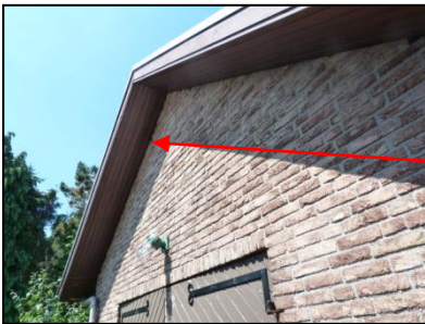
Figuur 5. Openingen dakrand bijgebouw.
