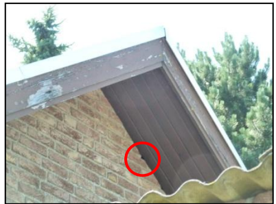
Figuur 7. Openingen dakrand bijgebouw.
