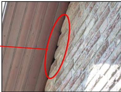
Figuur 6. Openingen dakrand bijgebouw.
