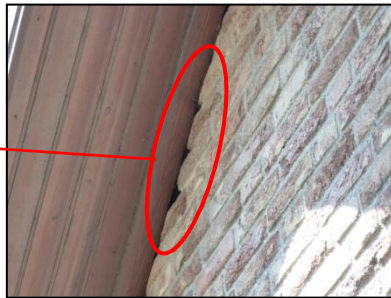
Figuur 19. Openingen dakrand bijgebouw.
