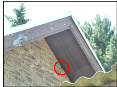
Figuur 20. Openingen dakrand bijgebouw.
