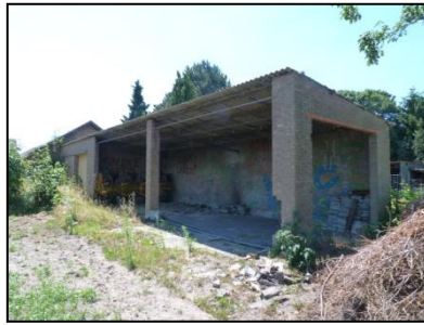
Figuur 10. Voormalige open kapschuur.
