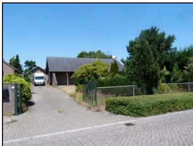
Figuur 3. Huidige oprit Hazelaarstraat 18.
