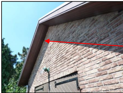
Figuur 18. Openingen dakrand bijgebouw.
