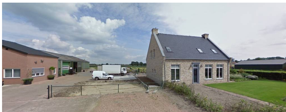
Afbeelding 5 - Bestaande bebouwing in het agrarisch bouwblok: rechts van het midden de bedrijfswoning, links de dienstgebouwen met expeditieruimte.
