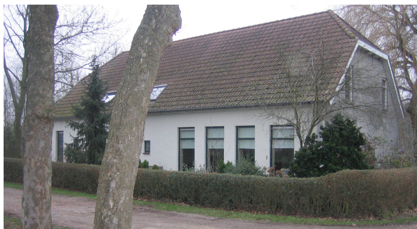
Voormalige bedrijfswoning, gezien vanaf de Zoeksedijk.
