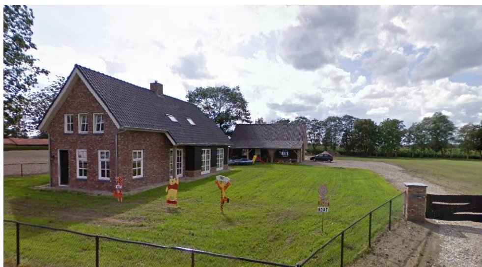
Afbeelding 06 - Overzicht bestaande situatie.
