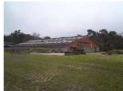
Noordelijke en westelijke gevel voormalige ligboxenstal
