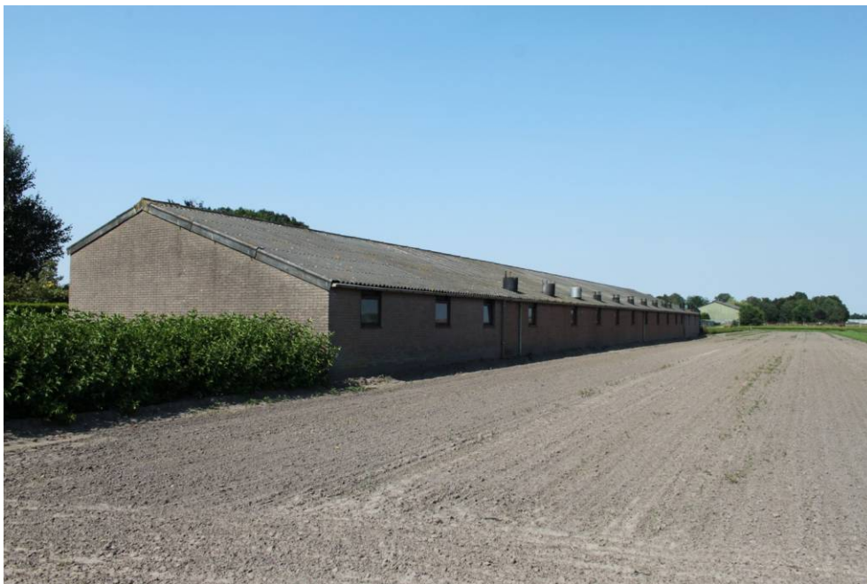
Afbeelding 7 - de andere bestaande stal bij het agrarisch bedrijf. Deze zal in zijn geheel worden afgebroken.
