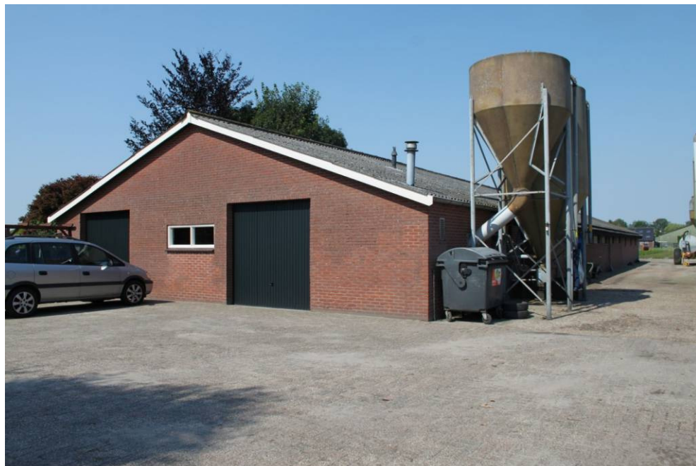
Afbeelding 6 - bestaande stal bij het agrarisch bedrijf Pauwenstraat 1A - het voorste gedeelte van deze stal zal worden gehandhaafd, het achterste gedeelte wordt afgebroken.
