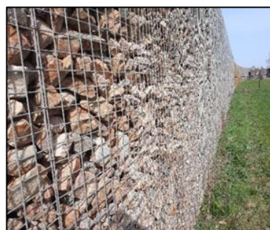
Figuur 11. Stenen muur ten noorden van locatie C.
