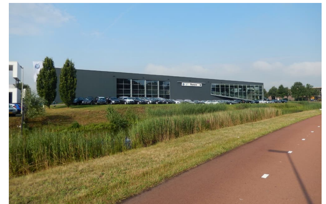
Kantoorgedeelte herkenbaar aan straatzijde
