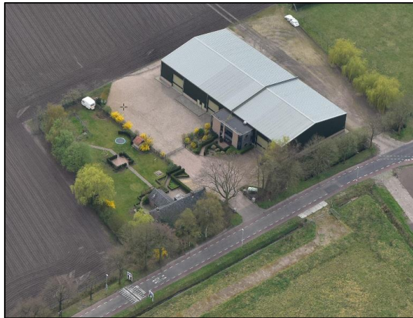
Luchtfoto van het plangebied voor sloop van de bedrijfswoning en bijbehorende opstallen (2016). Bron: Nedbrowser, 2016.
