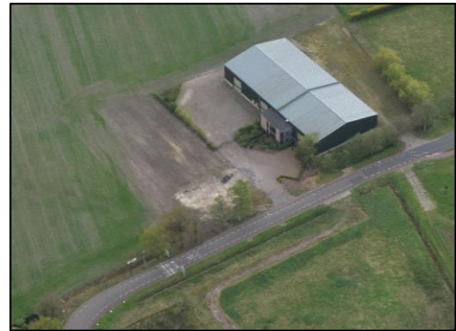
Situatie 2017. Bestaande situatie ter plaatse van het plangebied. Op het perceel is enkel nog sprake van de bestaande loods. Overige opstallen zijn gesloopt.
