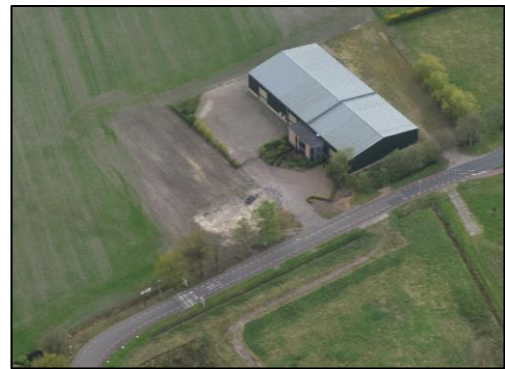
Situatie 2017. Bestaande situatie ter plaatse van het plangebied. Op het perceel is enkel nog sprake van de bestaande loods. Overige opstallen zijn gesloopt. Bron: Nedbrowser, 2017.
