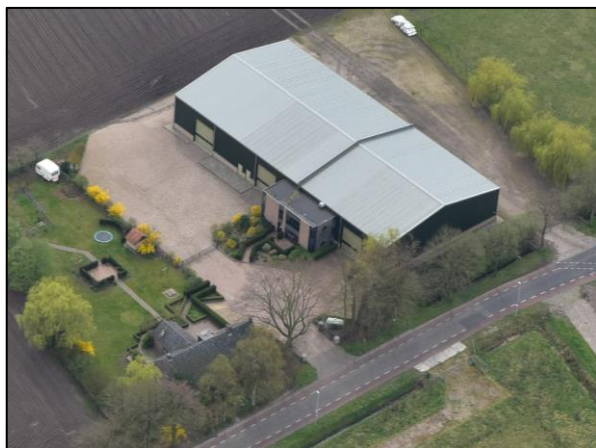
Figuur 2. Luchtfoto van de bedrijfsloods ter plaatse van de Kozijnenhoek 34 te Rucphen
