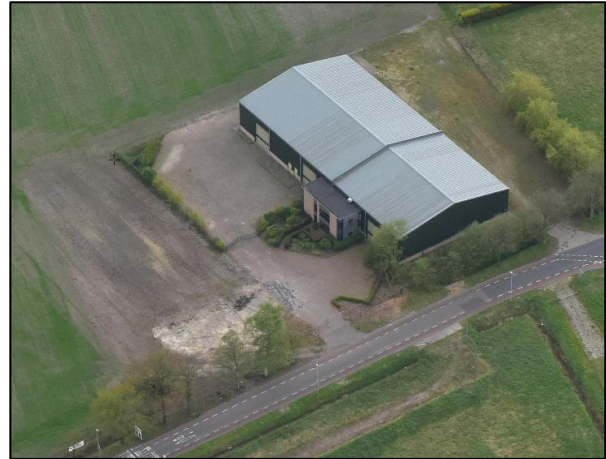
Luchtfoto van het plangebied na sloop van de bedrijfswoning en bijbehorende opstallen (2017). Bron: Nedbrowser, 2017.
