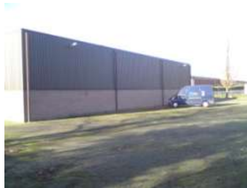
Oostelijke gevel parallel aan de Kerkeheidestraat
