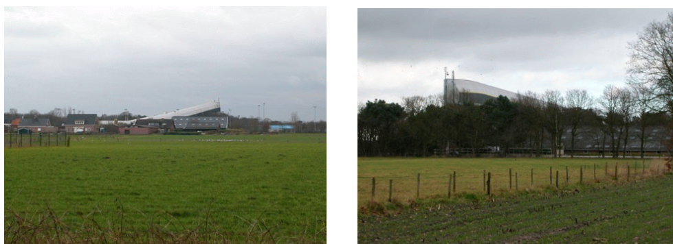
Zicht vanuit het zuiden (links) en het noorden (rechts) op de bestaande bebouwing (bron: Croonen Adviseurs)
