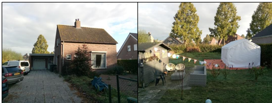
Figuur 3.2a (linkerfoto): Zicht op het zuidelijke deel van het plangebied gezien vanaf de Hoefstraat kijkende in noordelijke richting (d.d. 28-10-2019).
