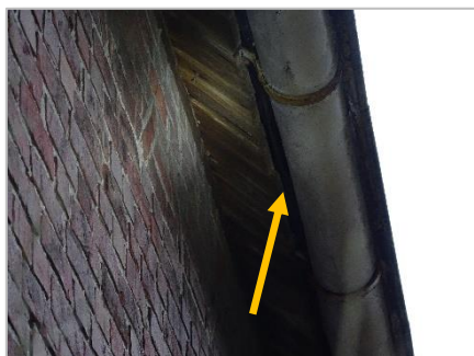
Foto 25: Goottrand dak mogelijke toegang vleermuizen) Hoefstraat 12 te Zegge.
