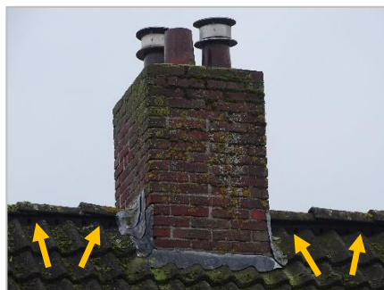
Foto 27: Nok dak mogelijke toegang vleermuizen) Hoefstraat 12 te Zegge.
