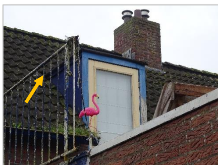
Foto 28: Dak bij dakkapel mogelijke toegang vleermuizen) Hoefstraat 12 te Zegge.
