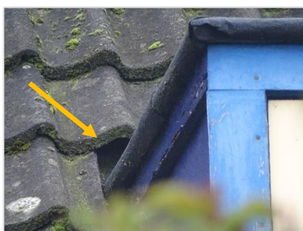
Foto 29: Dak bij dakkapel mogelijke toegang vleermuizen) Hoefstraat 12 te Zegge.
