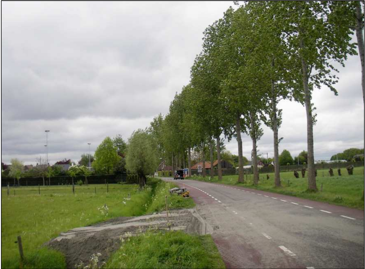
Figuur 1: Lage Zegstraat, kijkende in oostelijke richting. Het plangebied ligt links op de foto. Het pakket zand is van de bouwweg die wordt aangelegd..
