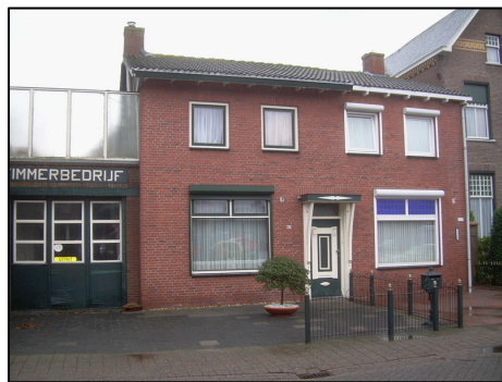
Voorzijde bedrijf en woonhuis.
