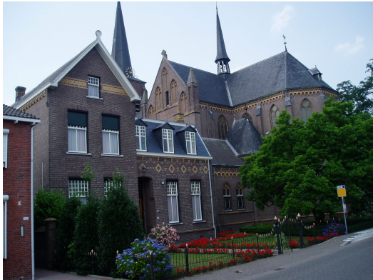
Figuur 2 Bebouwing ten noorden van de planlocatie
