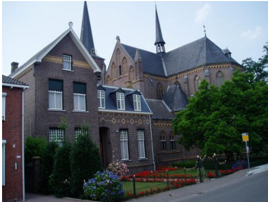
Figuur 2 Bebouwing ten noorden van de planlocatie
