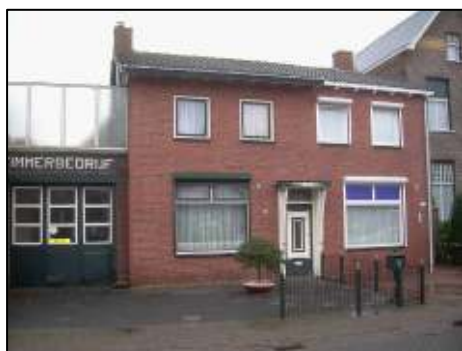
Voorzijde bedrijf en woonhuis.
