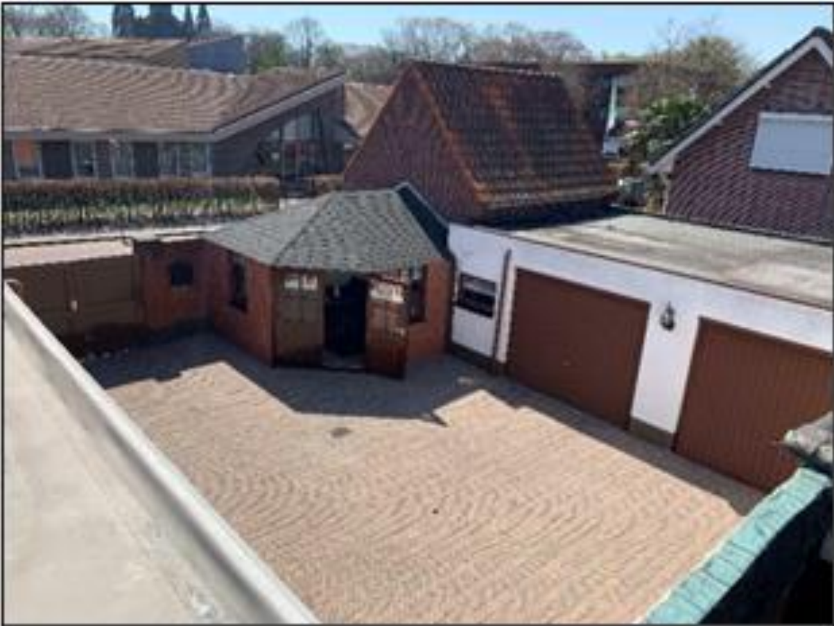
Transformatorhuis en achterterrein gezien vanaf de bebouwing langs de Dorpsstraat. Bron: Milon bv, 2021.
