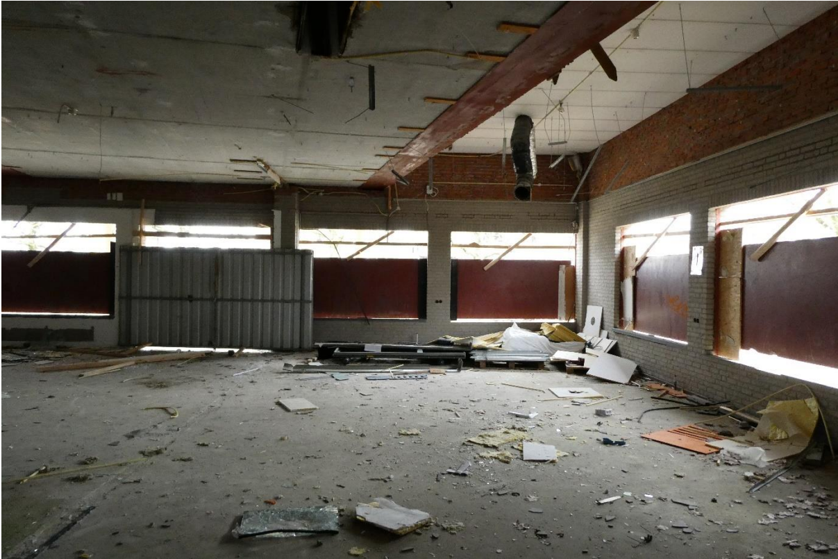
Afbeelding 3. Het interieur van het pand verkeerde ten tijde van het veldbezoek in een voorgesloopte toestand. Vloeren, systeemplafonds, verwarming en bedrading van elektriciteit was verwijderd.
