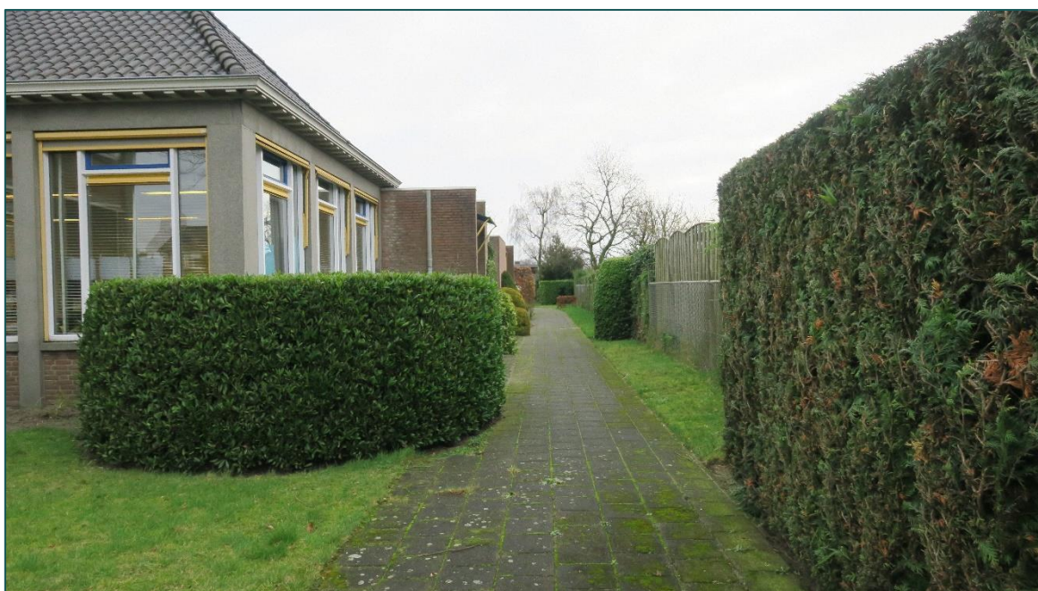
Figuur 3.2 Er is sprake van een toegankelijke dakruimte via de eerste rij dakpannen. Teven zijn er voldoende groenstructuren aanwezig in de directe omgeving. Derhalve is de aanwezigheid van nestlocaties van huismus niet uit te sluiten.
