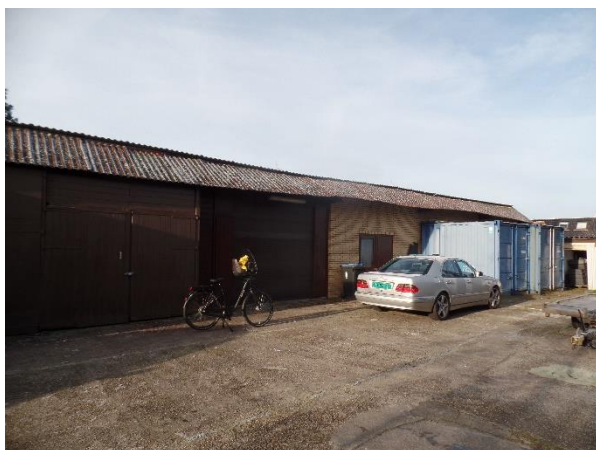
loods langs westelijke terreingrens.
