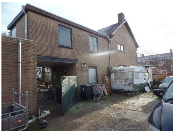
Tussenstuk tussen woonhuis en bedrijfsgebouw, gezien vanuit het westelijk deel van het erf.
