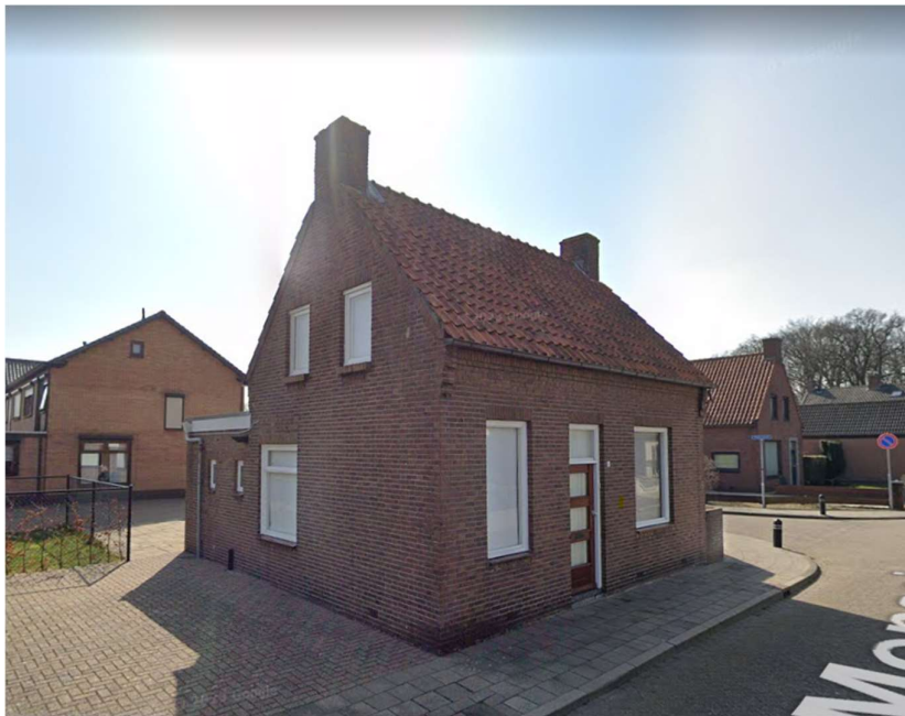
Figuur 3 Het te slopen huis.
