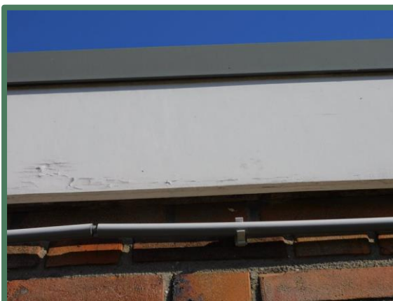
Aanbouw voorzien van aluminium rand en houten boeiboord, volledig gedicht met houten panlat
