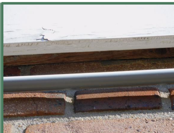
Aanbouw voorzien van aluminium rand en houten boeiboord, volledig gedicht met houten panlat
