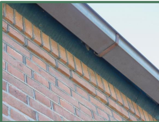
Ruimte onder goot afgewerkt en gedicht met hout
