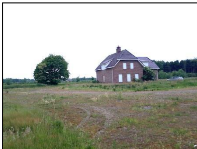
Figuur 3. Bebouwing op de locatie.
