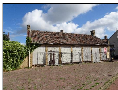
Figuur 8. Te slopen bebouwing op de onderzoekslocatie.
