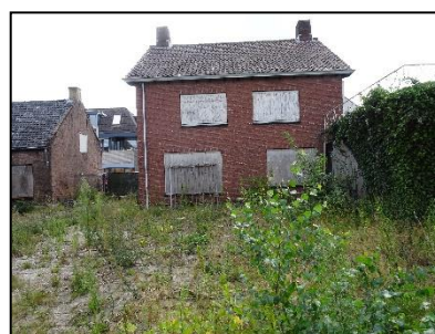
Figuur 5. Te slopen bebouwing op de onderzoekslocatie.
