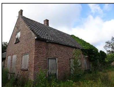
Figuur 4. Te slopen bebouwing op de onderzoekslocatie.
